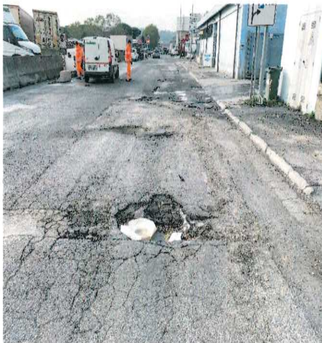
Foto_Esempi di ammaloramenti pavimentazione stradale nel porto di Ancona
