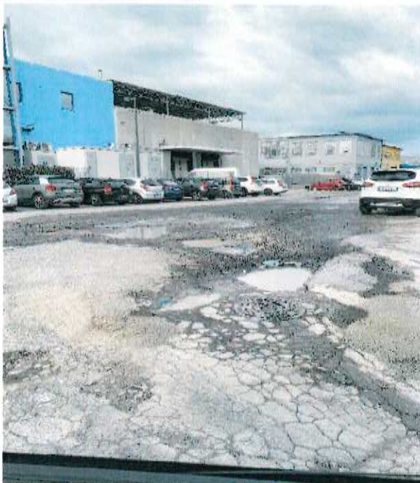
Foto_Esempi di ammaloramenti pavimentazione stradale nel porto di Ancona
